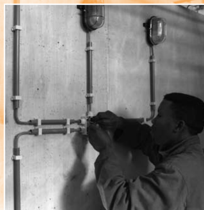
Als de basiskennis op orde is, oefenen deelnemers met het aanleggen van kabels ...
